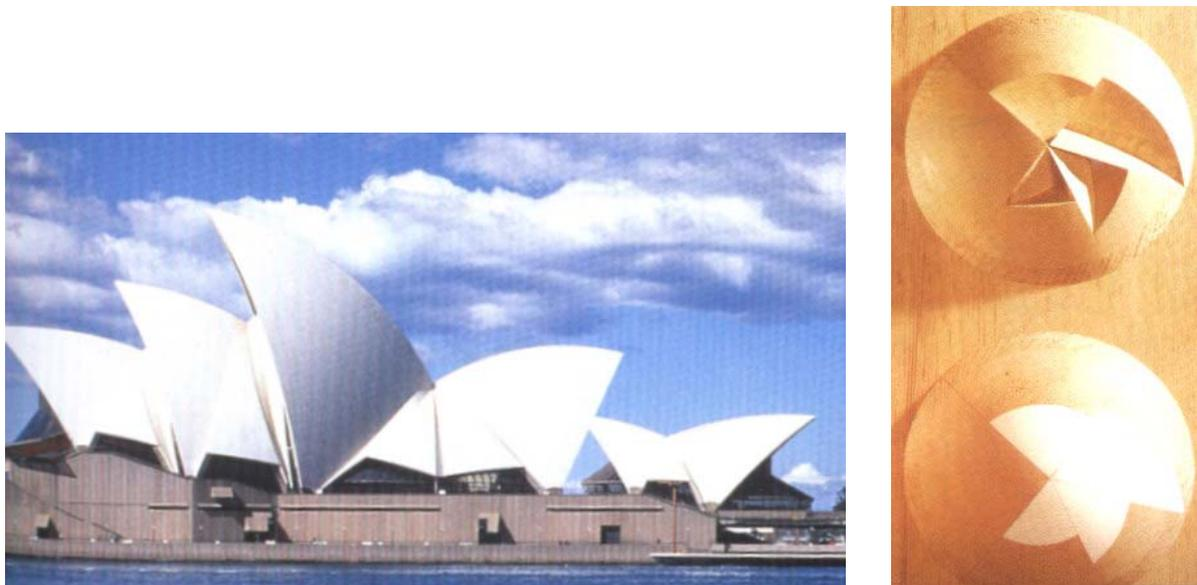
**Abbildung 15: Opernhaus in Sidney, 1957-1973, und die zu Grunde liegende Sphärengometrie**
